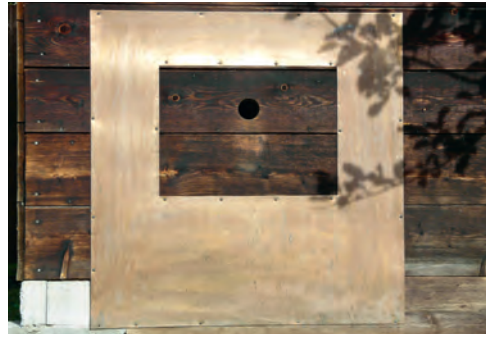
Abb. 4. Einflugloch zum Wiedehopf-Nistkasten im Gebäude, mit Marderschutzblech an der Aussenwand des Gebäudes. – Entrance hole to the nest box in the building, with protection plate against predators on the outer wall of the building.
